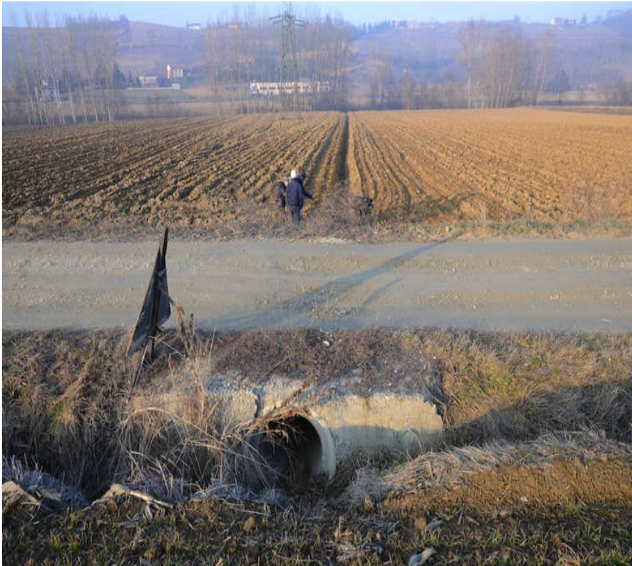
Rohr unter der Straße mit anschließender Furche fördert Runoff Wasser schnell zum angrenzenden Gewässer.
